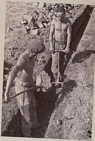
Die Gräben für die Drainagerohre wurden von Hand ausgehoben.
